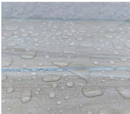
壓頂面現場試作：大面積潑水後結珠成串、基材保持乾燥。
